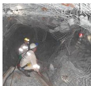
地震落盤現場でも岩盤応力測定が可能になった
