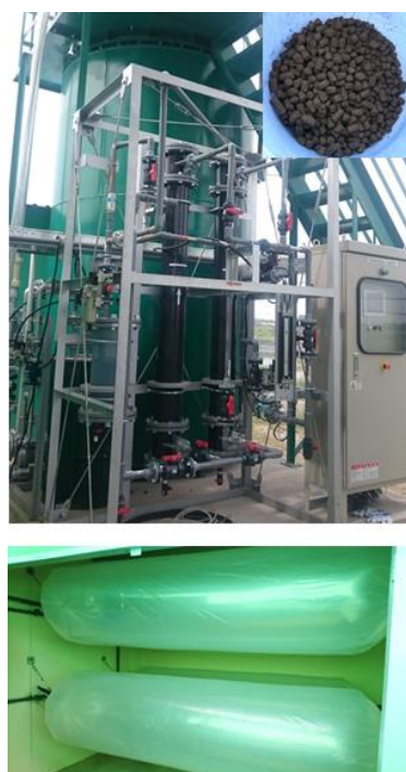
図 19 : (上) 酸化鉄ペレットを充填した脱硫塔を備えたメタン発酵槽実証機および(下) 樹脂製ガスホルダー
