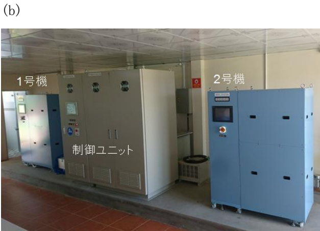
図 14：平成 29 年 12 月に実証サイト（ベトナム・ベンチェ省 Hoang Vu エビ養殖場）に設置した東南アジア初の 1 kW 級 SOFC 実証システム；(a) システム構成の模式図、(b) システム外観写真、(c) 平成 30 年 1 月末に実証サイトで行った 1 kW SOFC システムのバイオガス供給による発電試験結果
