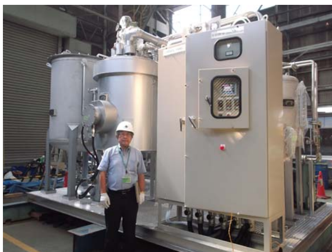
図 3-3 BDF製造パイロットプラント(容量 500L) (1日に3バッチの製造が可能:約 1.5t/日)
