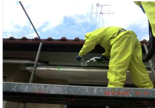
トタンひさし部の除染作業
