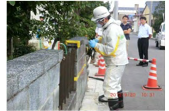
ブロック塀の除染作業
