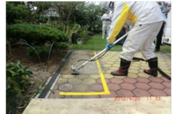
インターロッキングの除染作業
