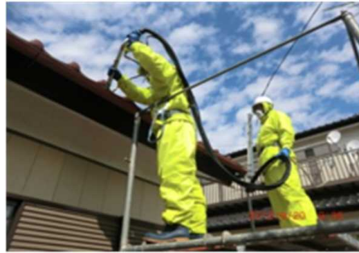
雨樋の除染作業
