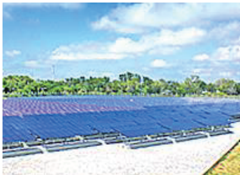
三菱商事の太陽光発電実証施設
