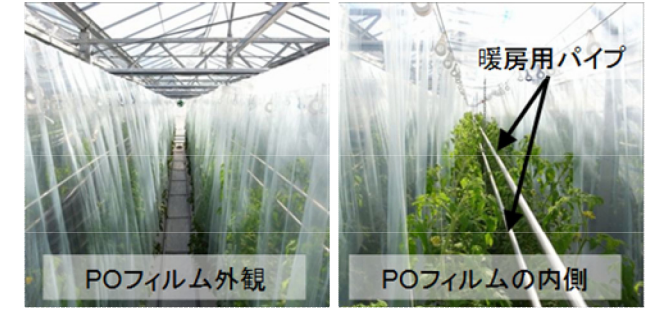
図2 生長点暖房システムの写真
