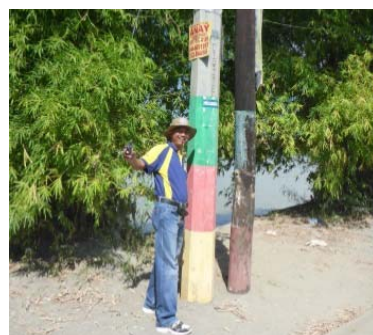
図 コミュニティ警報システムに用いる電柱
